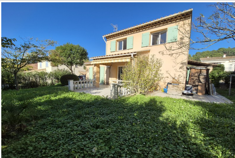
House 6288 La Roquette-sur-Siagne
